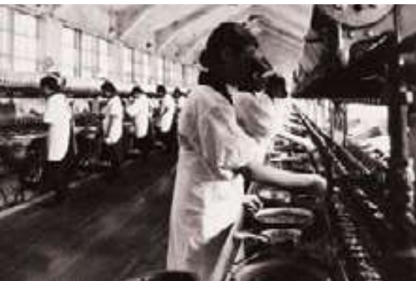
御法川式繰糸機（大正初期） 片倉製糸は御法川直三郎が発明した多糸繰糸機の 実用化に成功。高級生糸の量産と輸出に貢献した
