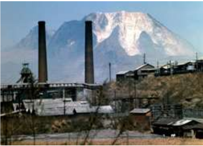
旧三井田川炭鉱の二本煙突 高さ45.45メートルの排煙用巨大煙突。炭坑節に歌われ、全国の盆踊りの楽曲としても親しまれている。この写真は、1964年の閉山時のもの
