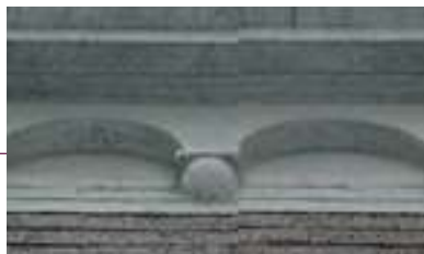
建物最上階のコーニス（軒蛇腹） ロマネスク風の小さなアーチが連続して施されている
