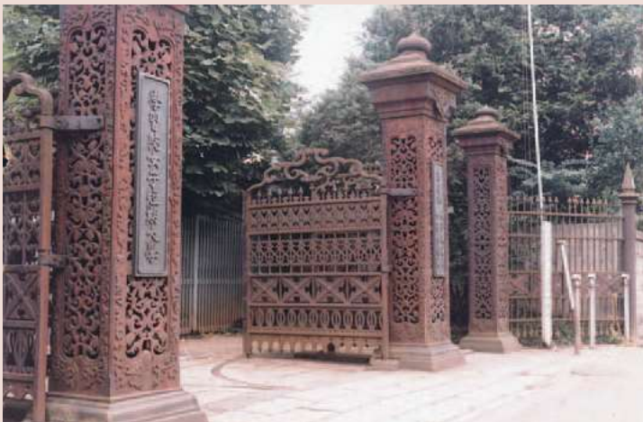
明治10年に学習院が神田錦町に開かれたときの正門。 唐草文様をあしらった鋳鉄製で、文明開化当時の様式をいまに伝えている。川口鋳造技術の真髄。
