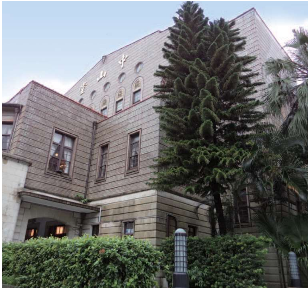
移転した大和町とは目と鼻の先にある「台北公会堂」。往時の姿をいまに伝えている。現在は「中山堂」と改称されている。
